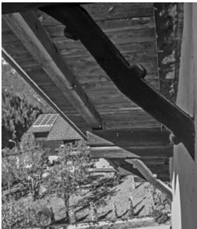
Ausschnitt der südlichen Giebelansicht, Detail der ausladenden Pfetten mit angeblatteten, rollenbesetzten Kopfstreben des Dachwerks von 1536
