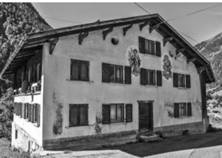
Ansicht über Eck; östliche Traufseite mit erdgeschossiger Mantelmauer, Fassadenansichten durch moderne Fenstervergrößerungen überformt. Der zu 1673 datierte Baukörper lagert unter einem flachen, bauzeitlichen 8 achsigen Satteldachwerk, Pfetten auf stufig abgesetzten bogigen vom Giebfeld ummauerten Konsolen.
