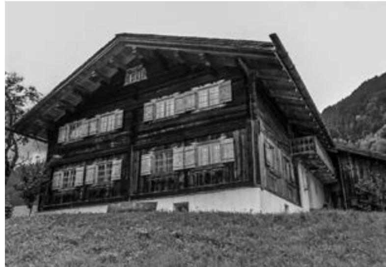
erscheint, mussten doch aufgrund des schlechten Bauzustandes viele Teile ersetzt werden. Vor allem der Verlust des alten Kellers (Wiederaufbau zum Teil mit modernen Materialien) sowie der neue Dachstuhl und die Balkone waren wohl unumgänglich.
