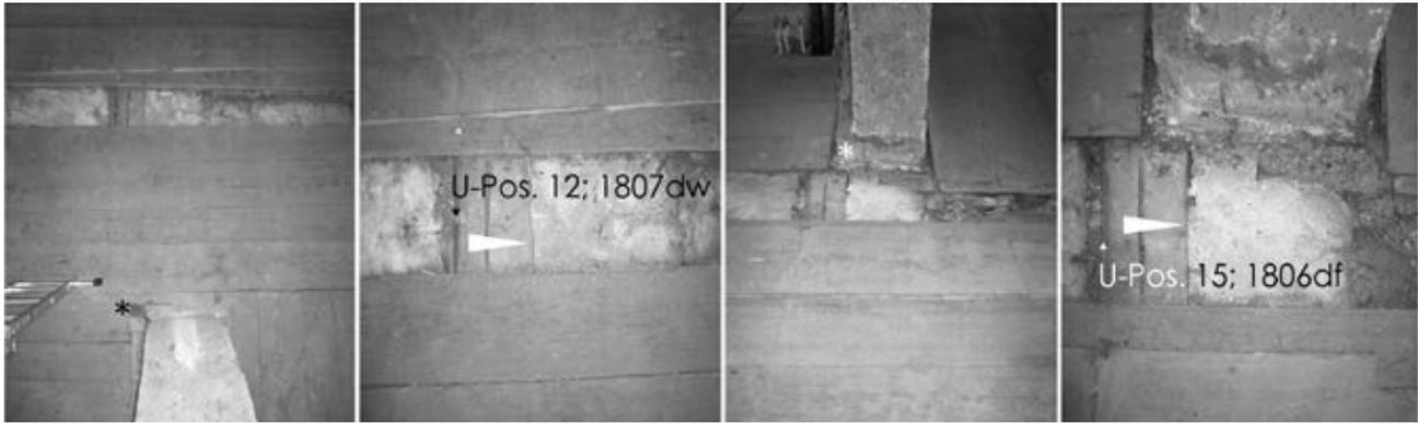
Anschluss-Situation des 11. (U-Pos. 12) und 7. (U-Pos. 15) Bodentragbalkens an die Mittelflurmauern des 2. Obergeschoßes
